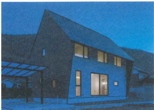
ひまし 長い庇とそで壁が特徴的。リビングに面した壁は窓が多く開放的で、駐車場側から見ると外観が五角形に見えます
