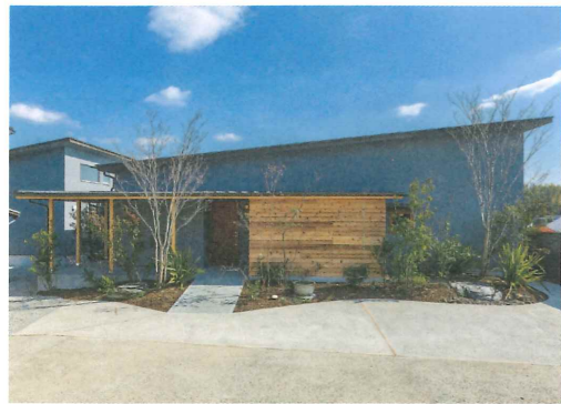
周囲の景観になじむ二世帯住宅の平屋は、片流れの屋根が特徴。グレーの塗り壁に映える鏡貼りがアクセントに
